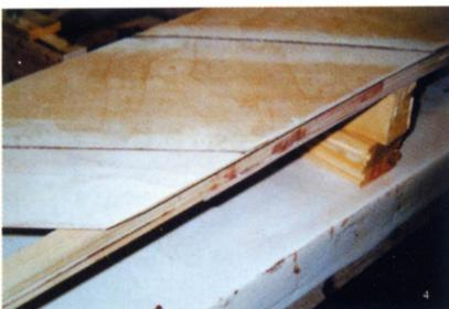
Photo 4 : Sens des fibres et entures sur le longeron.
