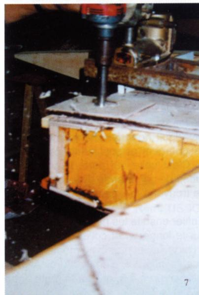
Photo 7 : Usinage des emplacements des tubes de train dans les caissons.
